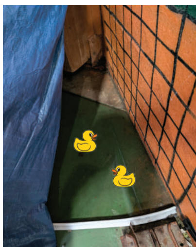
Angle du court 1 - installation d'une « piscine de rétention » et d'un « tipi de protection »
